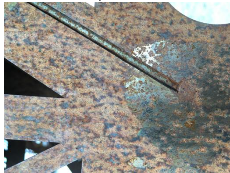
Détail de l'état de surface de la réplique de la Tour Eiffel de Cajarc
